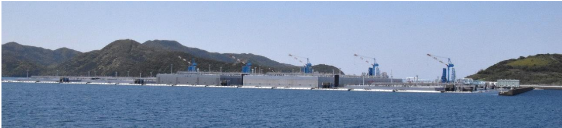
青方の洋上石油備蓄基地では、5つの大型のポンツーンに原油が蓄えられています。一部のポンツーンは浮き上がっており、これは原油が消費されたためです。
